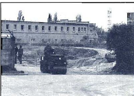
Foto: Voltairestr./neuer Eingang zur LVA
