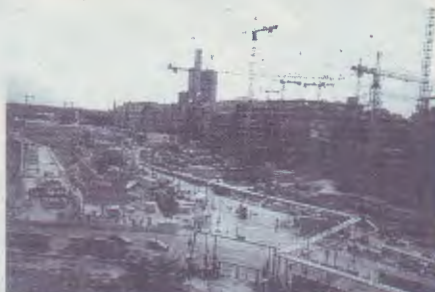
Baustelle „Potsdamer Platz“ die Daimler-Benz-Investition
