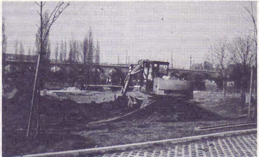
Verlegung der Hochdruckgasleitung im April 1999 auf dem ehemaligen BMW-Gelände
