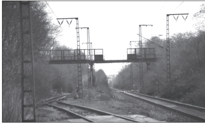
„Die alte Fußgängerbrücke beim Abriss“ (Aufnahme: Kohlswagen 1987)
