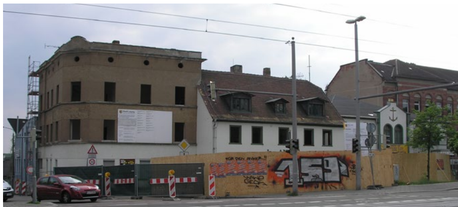
April 2014 - Die Arbeiten haben begonnen / Foto: K.-H. Kohlswagen
