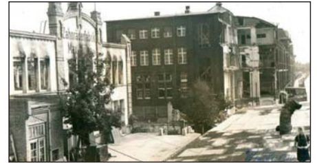
Firma Zahnrad-Müller (links) vor Abriss der 1. Etage und des Giebels; im Hintergrund die Pittler AG; Foto: Bruno Müller
