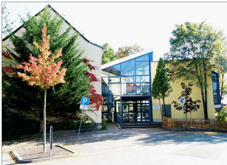
Der Eingang an der Gustav-Kühn-Straße
