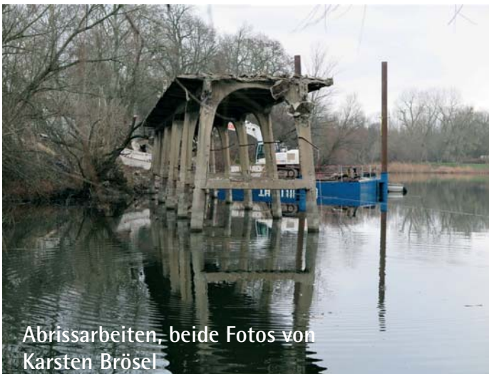
Foto im Dezember 2019, kurz vor den Abrissarbeiten Foto: Wolfgang Reinken
