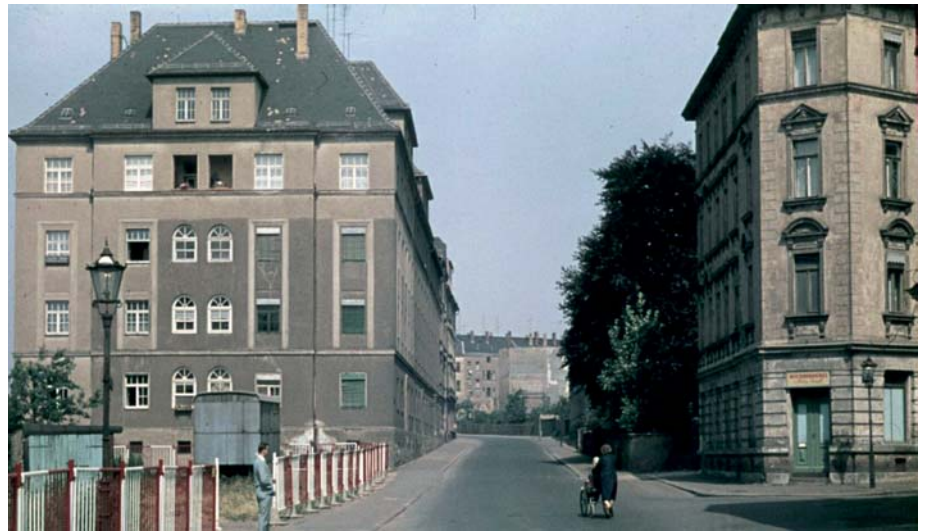
Blick in die Kirschbergstraße von der Bothestraße aus – an den Häusern links ist der Anstieg deutlich zu sehen. (1968; Archiv der Auferstehungskirche L.-Möckern)
