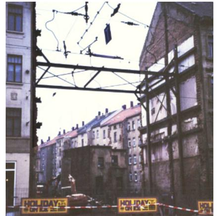
Die alte Nr. 197 ist abgebrochen, die beiden Nachbargebäude sind massiv abgestützt. Der Keller des Neubaus der Nr. 197 ist im Entstehen. Im Durchblick sieht man das Hinterhaus der Nr. 199. Foto: Dez. 1995.
