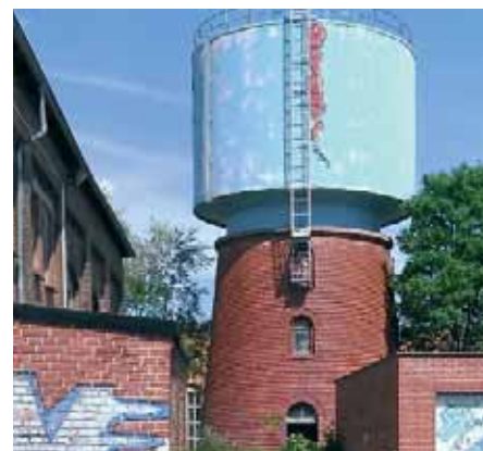
Wasserturm u. Schaltwerk Rackwitzer Straße
