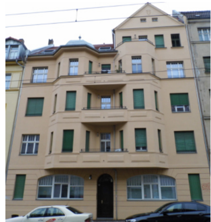
2015 wurde das Gebäude saniert. (Foto: Karl-Heinz Kohlwagen)
